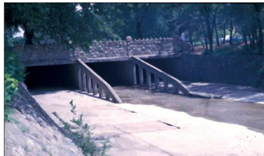
Hình 6. Xây dựng tường cánh dẫn hướng cây trôi ở thượng lưu của trụ cầu [4], [7].
