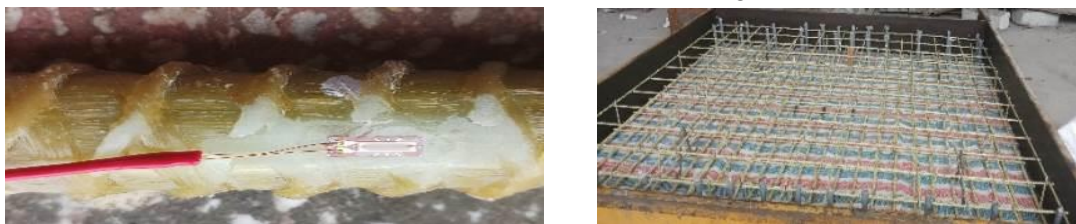
a) Lắp đặt cảm biến đo biến dạng trên cốt
