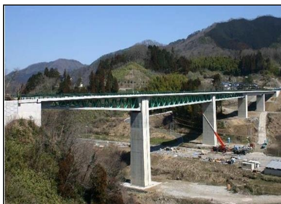
Hình 2. Cầu dầm hộp bê tông dự ứng lực có sườn dàn ống thép [2].
