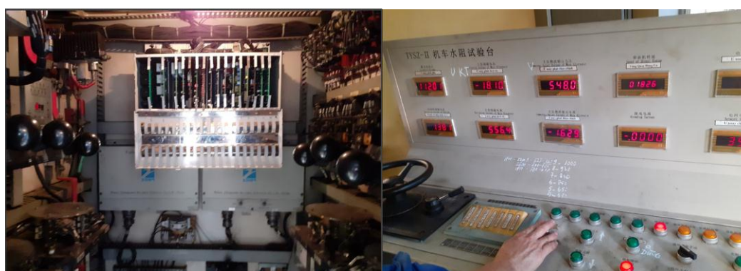
Hình 7. Lắp đặt trên đầu máy và thử nghiệm trên bệ thử công suất tại XN đầu máy Hà Nội.
