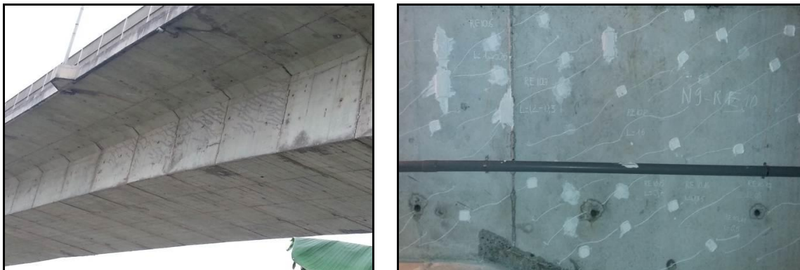
Hình 1. Hình ảnh nứt xiên vách dầm hộp ở cầu Tân Đệ, QL10.
