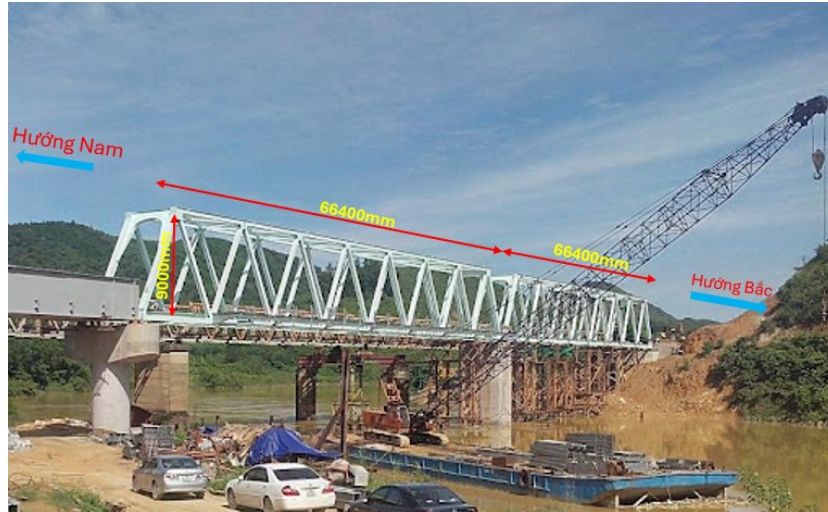
Hình 3. Cầu Cửa Rào, Hà Tĩnh.
