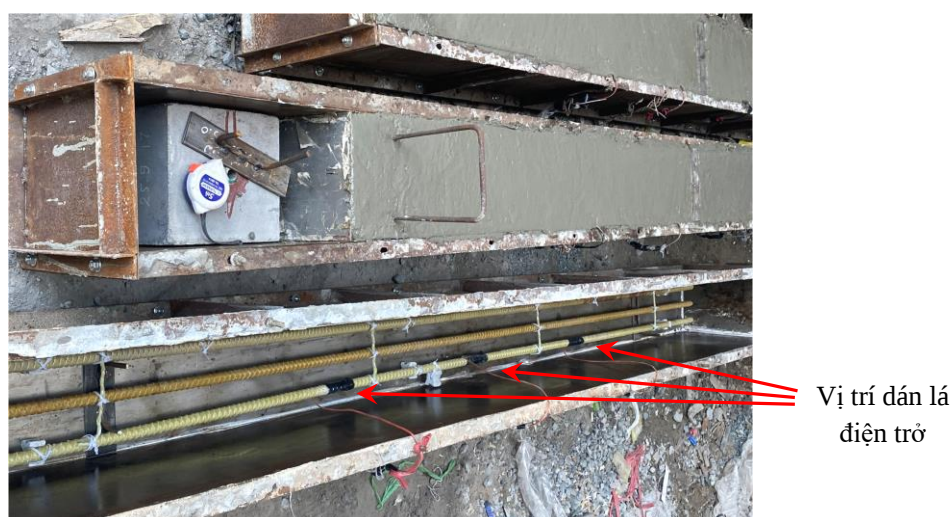
Hình 2. Chế tạo dầm bê tông geopolyme.
