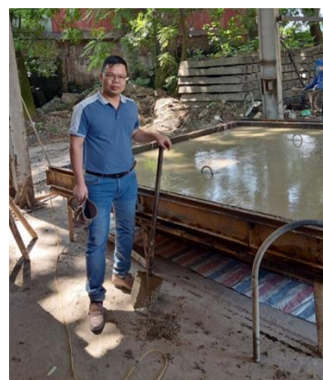
b) Bản mặt cầu ngay khi hoàn thiện đổ bê tông
