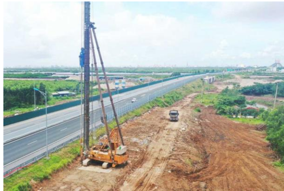
Hình 1. Thi công cọc xi măng đất cạnh các công trình lân cận [17].
