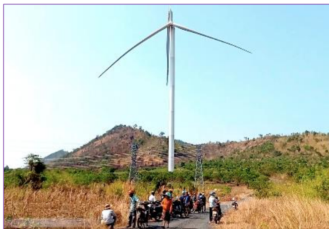
Hình 1. Gãy cánh quạt điện gió tại dự án Ia Le 1-Gia Lai vào tháng 4/2024 [13].
