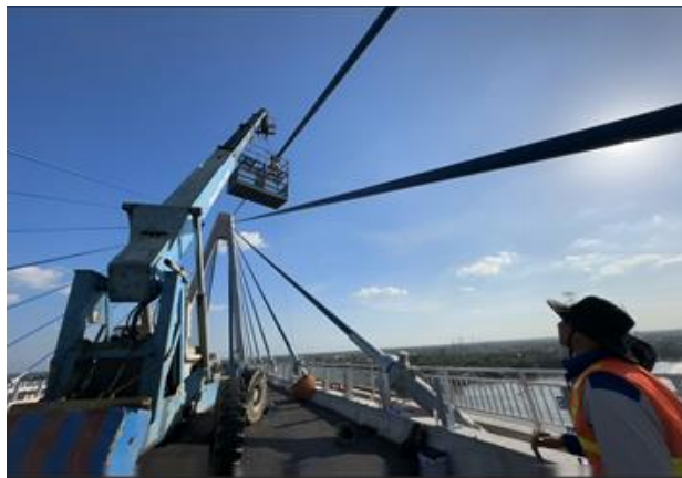
Hình 9. Vị trí cáp văng thực hiện đo đạc – cáp T16R-MC16 (Hình ảnh được chụp bởi tác giả vào 17/12/2023).
