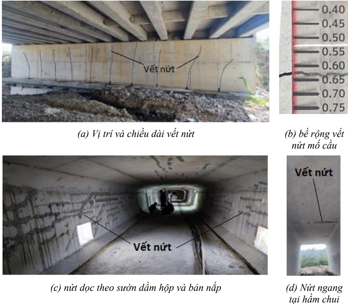
Hình 1. Các vết nứt xuất hiện ở các kết cấu cầu điển hình.
