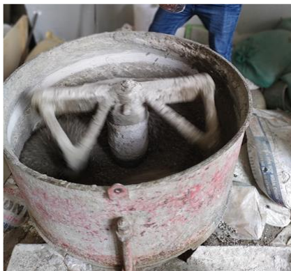
Hình 4. Trộn hỗn hợp bê tông đất bằng máy trộn cưỡng bức.
