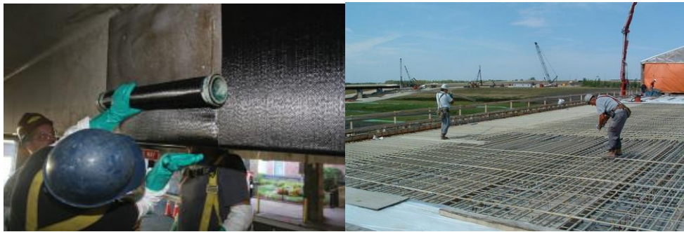
Hình 1. (a) Tấm gia cường trong KC dầm BTCT [1] (b) Thanh GFRP trong kết cấu cầu [2].
