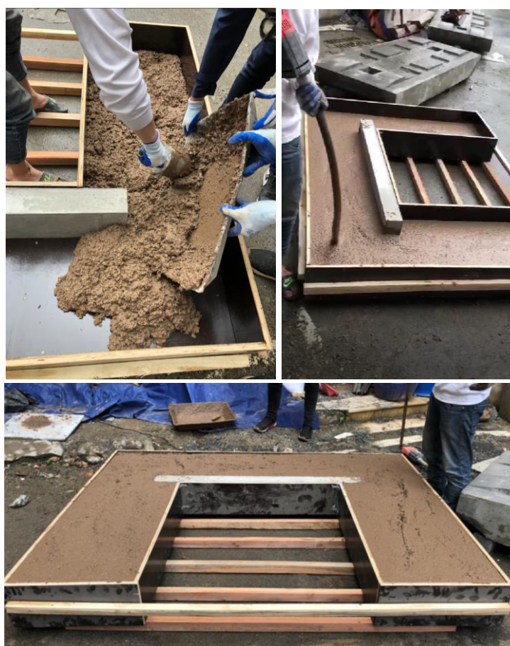
Hình 1. Đổ và đầm bê tông trong ván khuôn gỗ.
