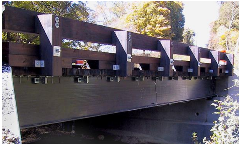
Hình 1. Cầu đường bộ sử dụng dầm GFRP [2].
