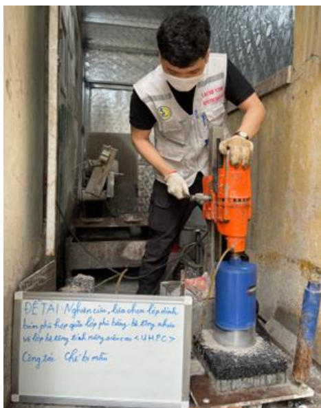
Hình 2.5. Khoan mẫu hai lớp BTN và UHPC.
