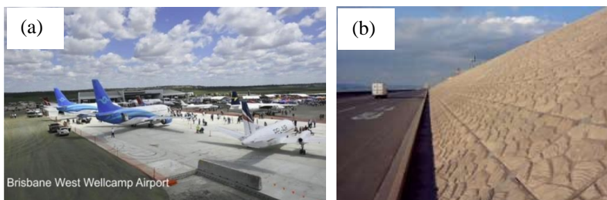
Hình 1. Mặt đường sân bay Wellcamp, Úc (a) và tường chắn sóng ở Kurashiki, Nhật Bản (b) xây dựng bằng bê tông geopolimer.
