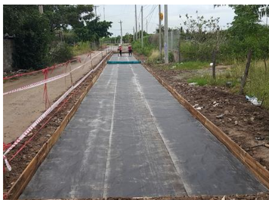
Hình 4. Hoàn thiện lớp vải địa kỹ thuật tạo phẳng.
