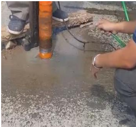
Hình 13. Khoan mẫu trên mặt đường bê tông geopolyme.
