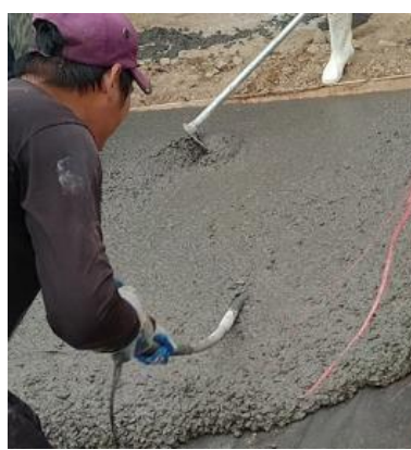
Hình 6. Công tác đầm bê tông geopolyme.
