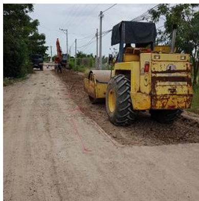
Hình 3. Công tác lên khuôn nền đường.
