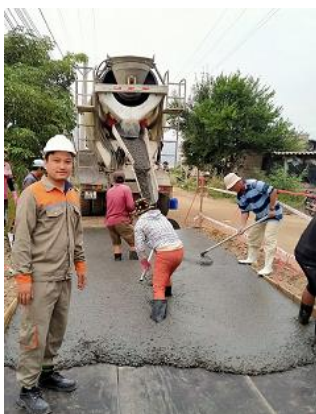
Hình 5. Công tác đổ bê tông geopolyme.
