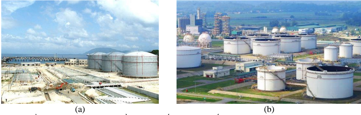
Hình 1. Bể chứa của nhà máy lọc dầu tại một số dự án kinh tế của Việt Nam: (a) Vũng Rô-Phú Yên [16] và (b) Dung Quất-Quảng Ngãi [17]
