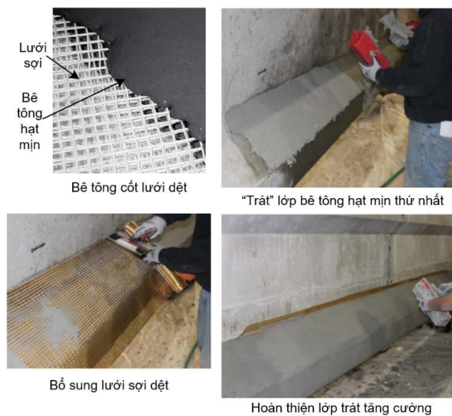
Hình 1. Gia cường dầm bê tông cốt thép bằng bê tông cốt lưới dệt [12,13].
